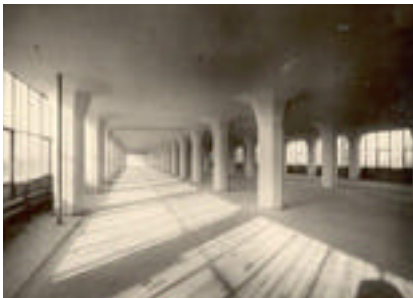
Planta libre antes de la intervención (foto WdeJ)
