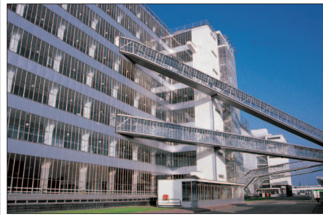
La ex fabbrica Van Nelle a Rotterdam dopo il restauro
